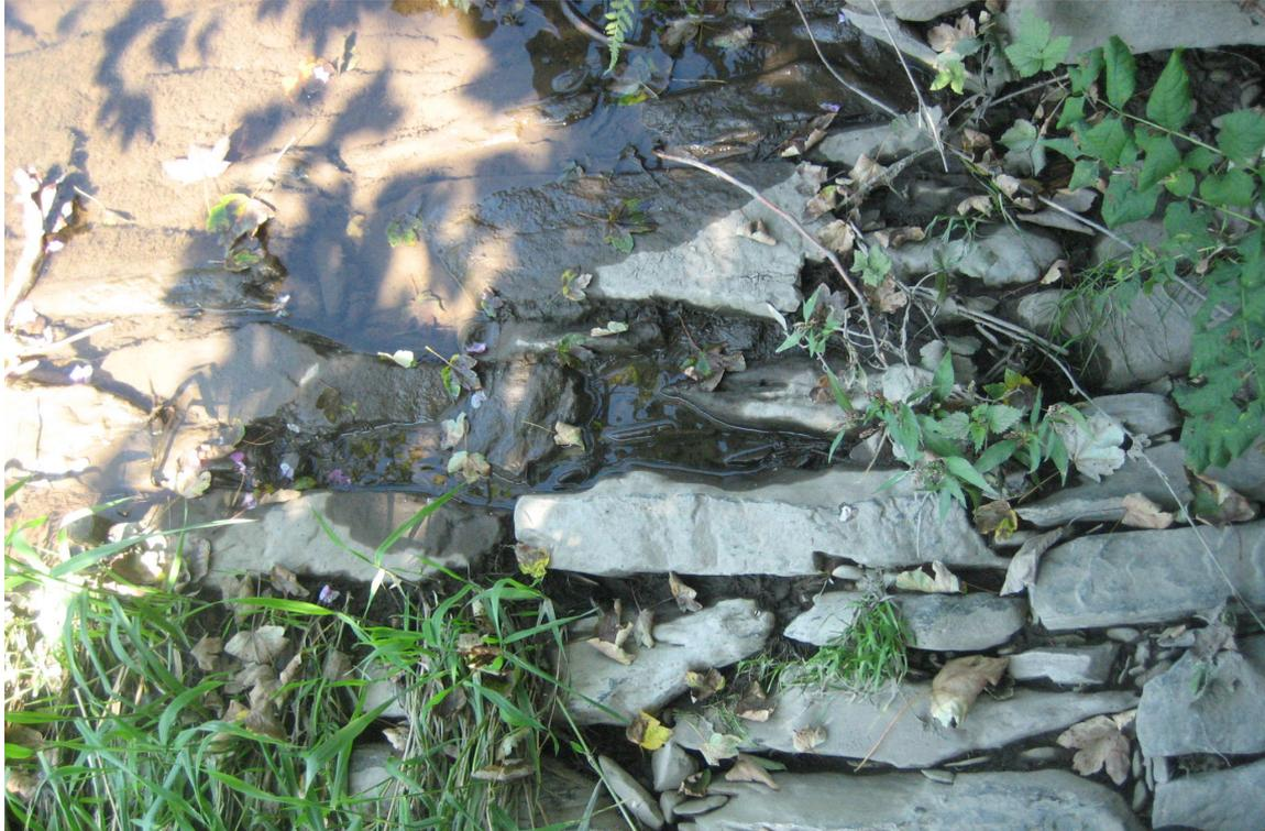
Details wie das Spickpflaster, mit dem noch große Teile des Jung'schen Wehr befestigt sind – vgl. Abb. 4.
