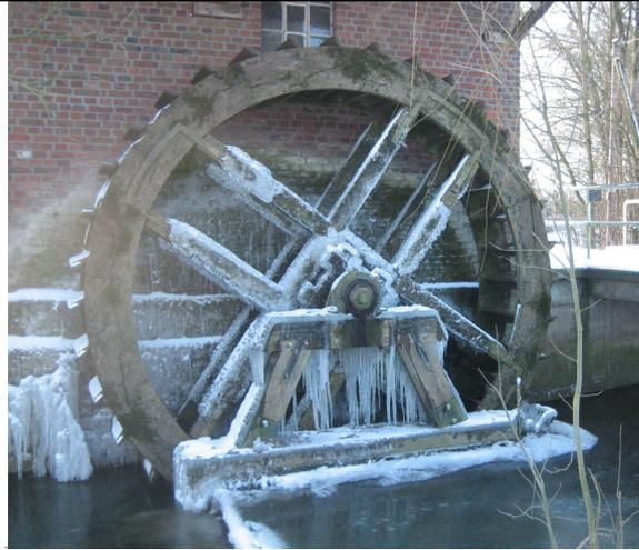
Abb. 5: Klostermühle an der Münster'schen Aa südwestlich von Münster; das Mühlrad wird langsam morsch, ebenso die Klinkermauer hinter dem Mühlrad; mehrere Anläufe zu einer Restaurierung schlugen fehl, entsprechend scheiterten auch Versuche, die Aa hier – mit recht einfachen Mitteln – durchgängig zu machen – ein Beispiel, wie fehlende Mittel zum Denkmalschutz auch ein Gewässer blockieren
