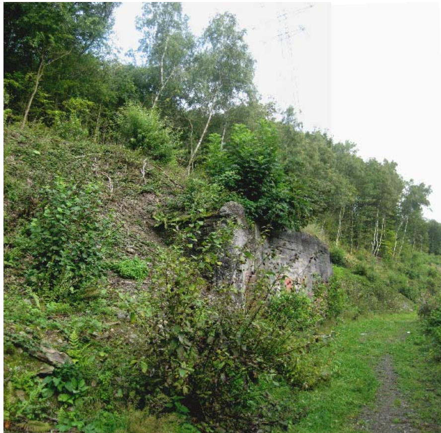
Abb. 9: Stollenmundloch am rechten Siegufer in Eiserfeld
