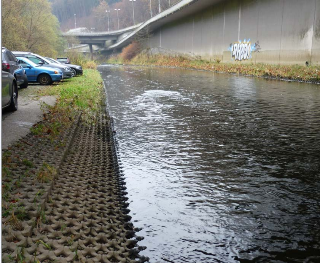
Abb. 42: Die Sieg oberhalb der Verrohrung, quasi als Nachtrag zur Auenentwicklung: Die Sieg ist bereits voll begradigt, beiderseits ist die Sohlpflasterung erkennbar und die Verrohrung kündigt sich bereits über balkonartig über den Fluss gezogene Straßen an; bei Niedrigwasser wird die frühere Aue auch gleich noch als Stellplatz genutzt und ist deshalb auch vorsorglich gepflastert.
