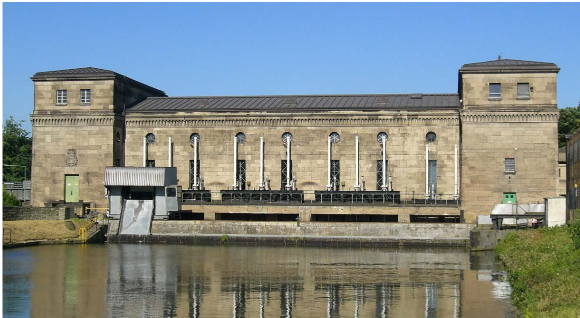
Abb. 7 9 /8 10 : Kraftwerk Raffelberg in Mühlheim/Ruhr. Die wie in der Freusburgermühle in den 1920er Jahren eingebauten Francis-Turbinen stehen mit dem Gesamtensemble unter Denkmalschutz; rechts im Bild oben der etwa zehn Jahre alte Fischpass; das Kraftwerk leistet ungefähr das 50-fache der Freusburger Mühle
