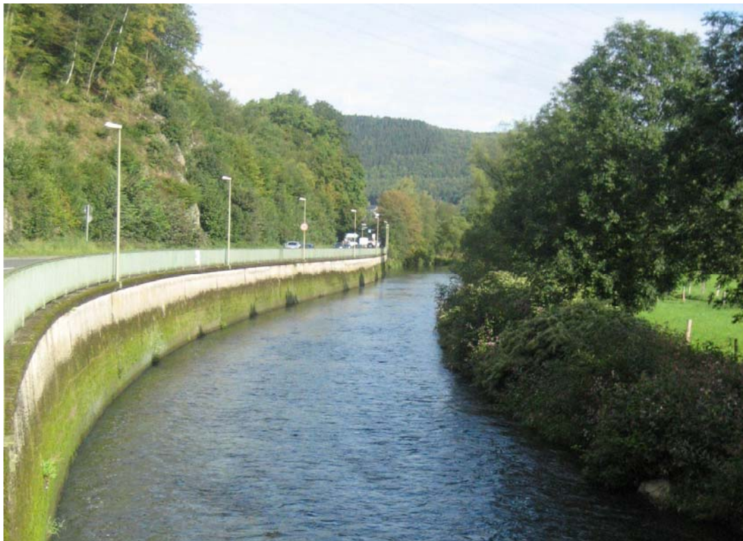
Abb. 22: Sieg oberhalb von Niederschelden; das linke Ufer wird von einer Betonwand mit Geländer markiert, das rechte Ufer ist von Neoppythen besiedelt, Ufergehölze fehlen stellenweise auch dort, der Rest der früheren Aue wird als Grünland genutzt
