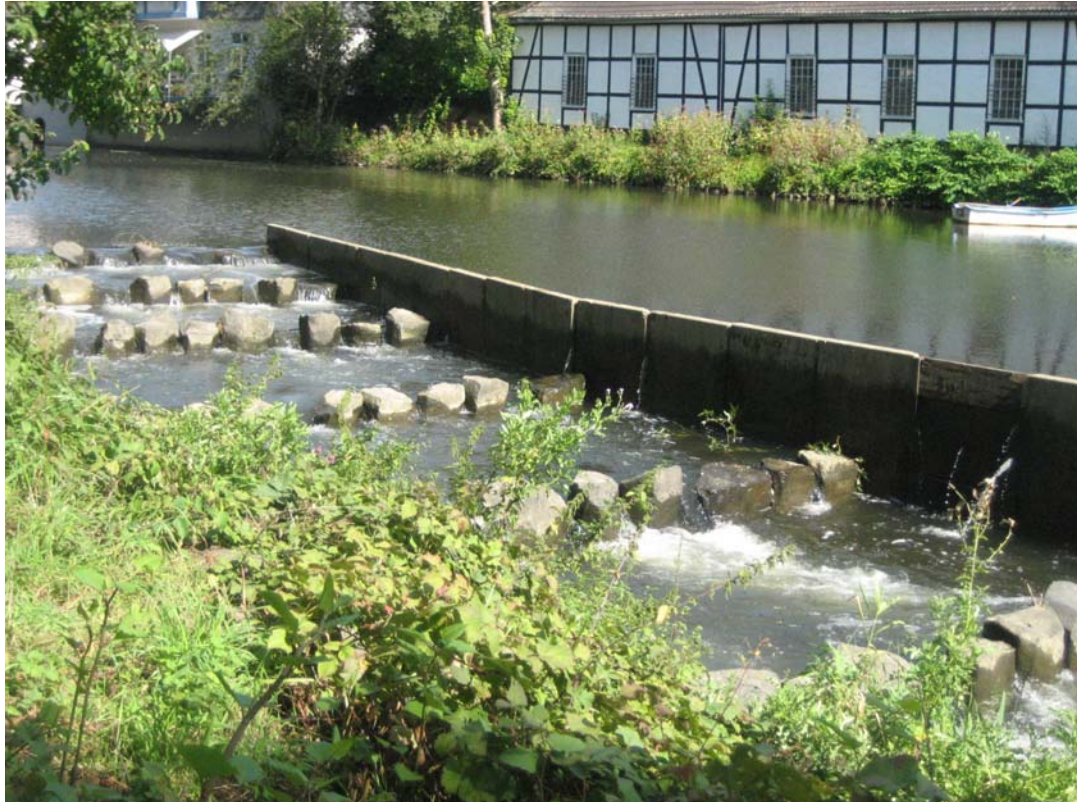
Abb. 38: Raugerinnepass bei etwa 60% der Mittelwassermenge; gut erkennbar die starken Turbulenzen in einzelnen Becken
