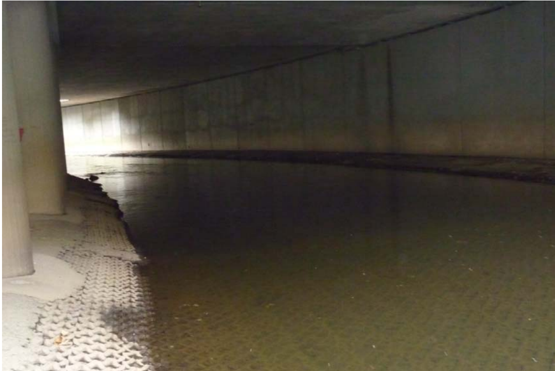
Abb. 43: Verrohrte Sieg, die an dieser Stelle auf den ökologischen Wert eines unterirdischen Regenrückhaltebeckens reduziert wurde, wobei an keiner Stelle dieser Bereich als Hindernis für die Durchgängigkeit dokumentiert wurde.
