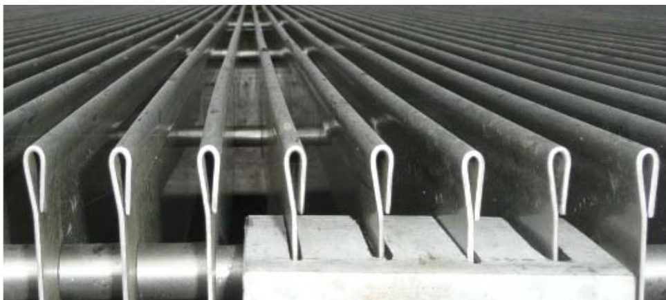
Abb. 71: Fischschonrechen, der zwei Vorteile besitzt: Bei 12 mm Spaltweite wird kein größerer Aufstau erzeugt als bei konventionellen 20 mm Rechen; damit wird Ökologie und Wasserkraft gleichermaßen Rechnung getragen. Zudem lässt sich ein Schöpfblech vorschalten, über das abwandernde Fische, die oberflächennah schwimmen, vom Rechen abgehalten werden und über eine temporär beschickte Fischrutsche ebenfalls dem Stau vor dem Jung'schen Wehr zugeleitet werden können.
