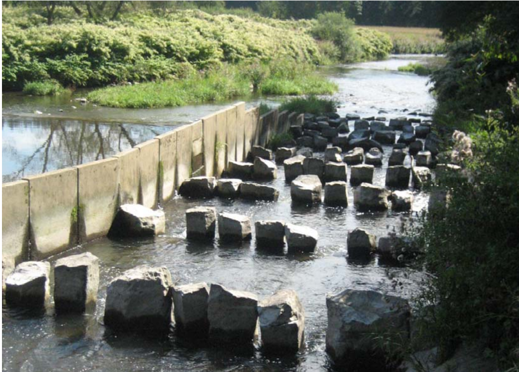
Abb. 58: Mehrlückensystem des Raugerinnepasses, welches Beruhigungs- und Rückströmungen fast unmöglich macht. Schwimmschwache Fischarten haben praktisch keine Möglichkeit, dieses Gerinne aufwärts zu passieren.
