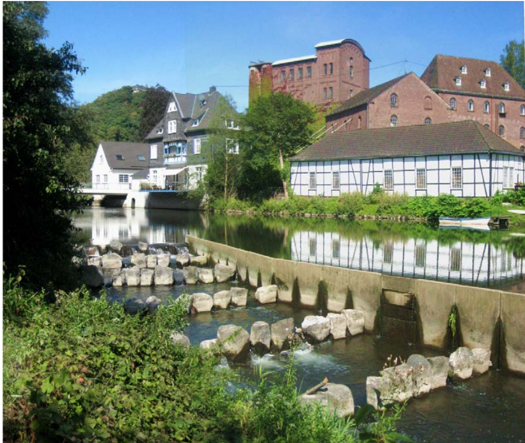
Abb. 37: Raugerinnepass bei Niedrigwasser; gut erkennbar die Öffnungsschlitze zwischen den Setzsteinen, die zwischen 0,05 und 0,50 m variieren; in einzelnen Reihen beträgt die maximale Schlitzbreite 30 cm.
